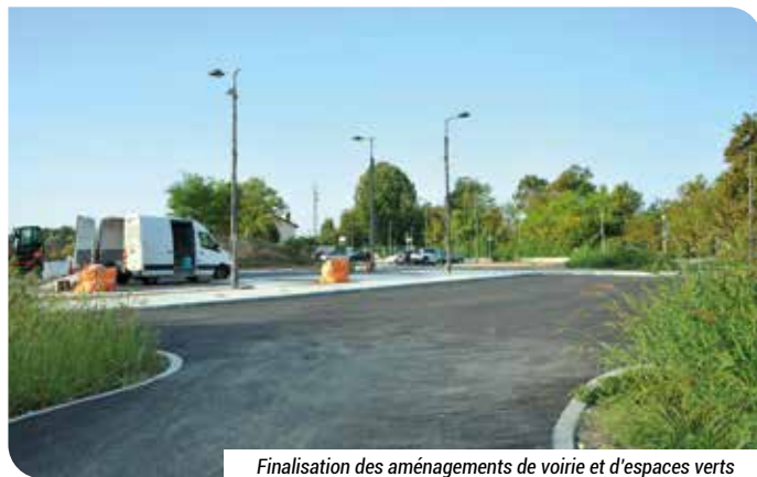
Finalisation des aménagements de voirie et d'espaces verts
