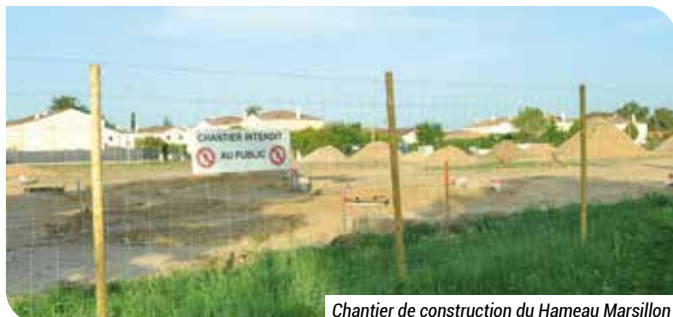
Chantier de construction du Hameau Marsillon
