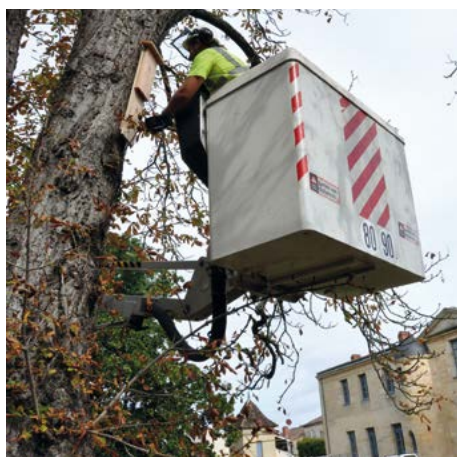
Installation nids de chauve-souris 1 er octobre - Parc Charron
