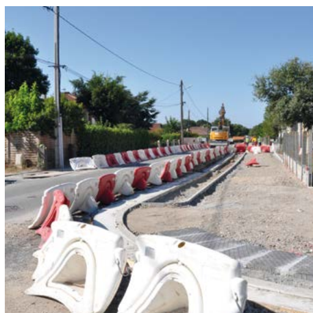
Travaux rue de Formont fin août - septembre
